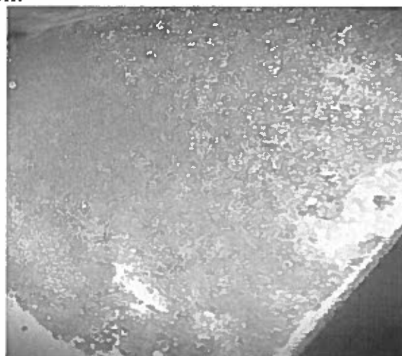
После механической очистки
